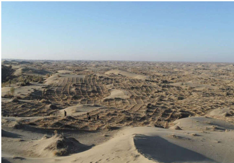
Рис.2. Установка клеточных механических защит на техногенных песках.
