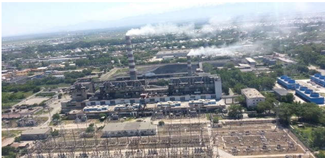
Рис. 2: Центральная часть АО «Алматинская Электрическая Станция ТЭЦ-3».
